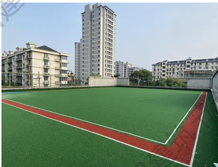
图 18-5 车库地面出入口的屋顶建设为运动场
