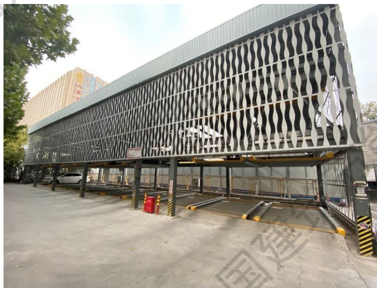
图 16-3 苏州胡同西口的一处升降横移类机械式停车设备
