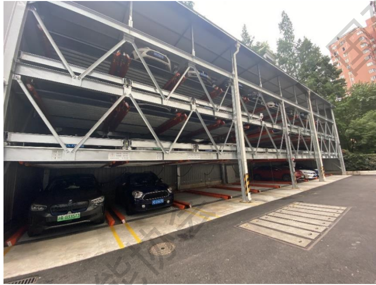
图 14-3 原址新建的 4 层升降横移立体车库
